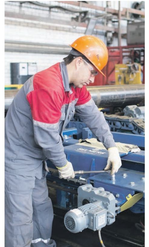
△ На участке АКП ТЭСЦ-3 смонтировали голландские машины © ВАЛЕРИЙ ПОКУМЕЙКО
